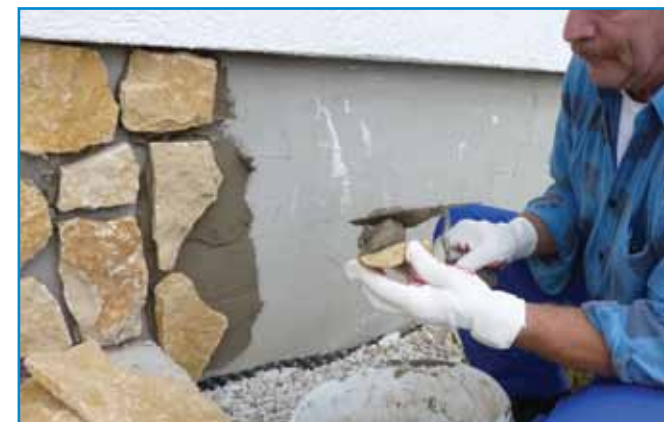
Az alapfelületet és a burkolólapot is bőségesen kenjük meg ragasztóhabarccsal.
